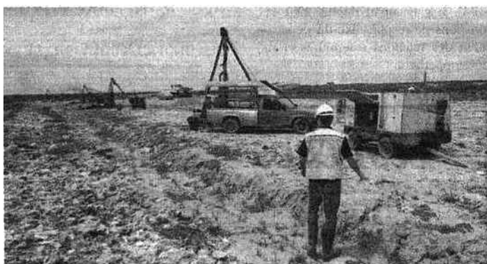
Forage du site de Thaïlande pour l'implantation du réseau de captage du biogaz.
